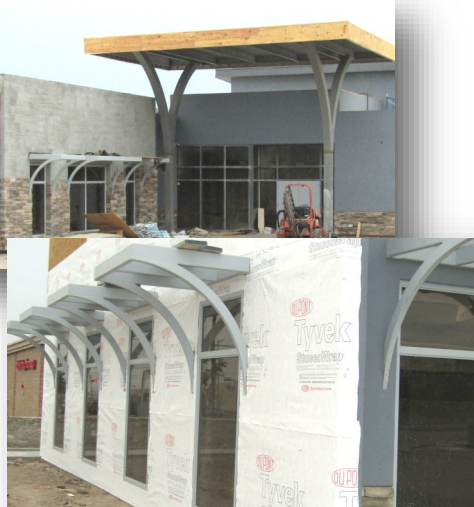
Fotos de la construcción en junio.
